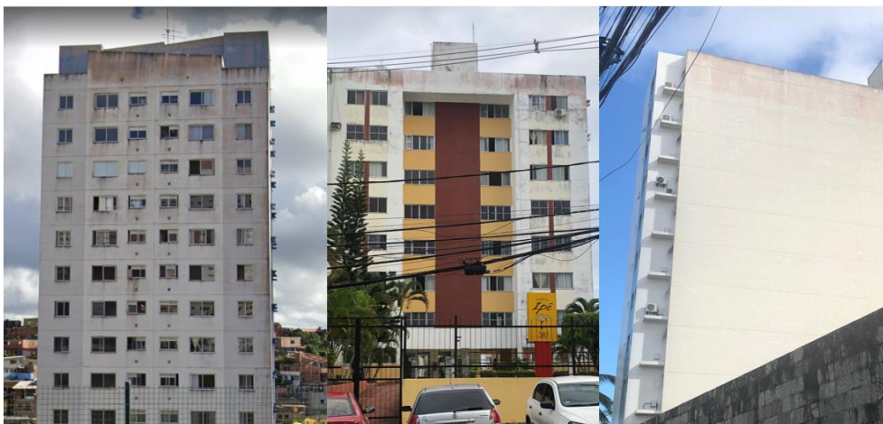
Figura 10 - Concentração das manchas vermelhas nos pavimentos superiores
