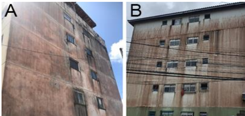
Figura 1 - Manchas vermelha proveniente do biofilme vermelho
