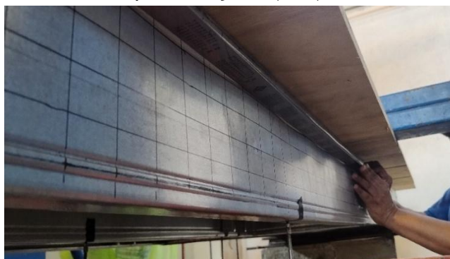
Figura 16 - Flambagem local da alma no perfil da laje L-2 (CP-B)
