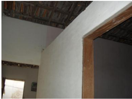
Figura 7 - Alvenaria divisória da zona de dormir
