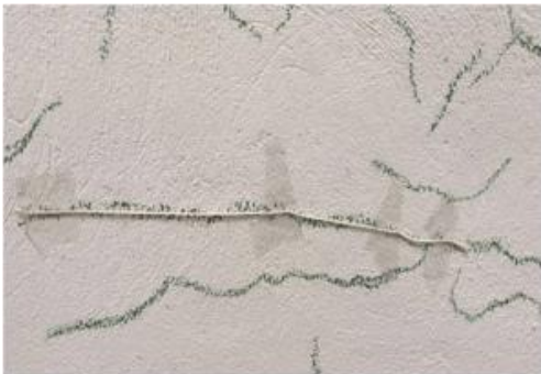
(c) Aferição do comprimento com o auxílio do barbante
