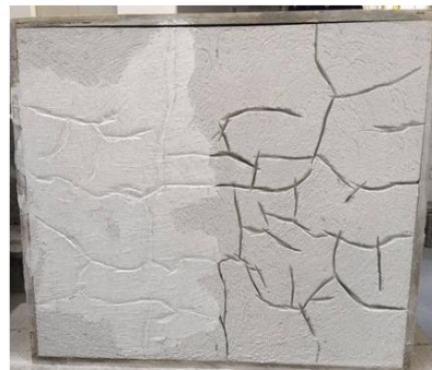
(b) Preenchimento dos sulcos com massa acrílica
