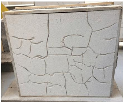
(a) Abertura dos sulcos
