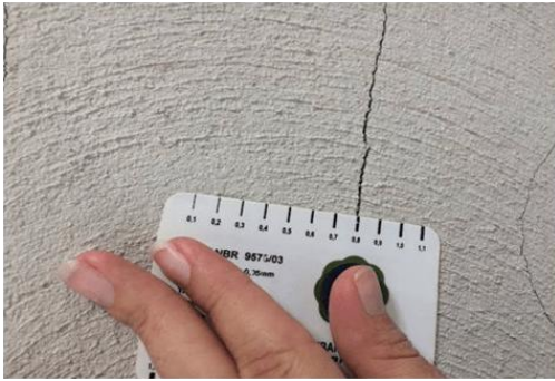
(a) Medida da espessura com fissurômetro
