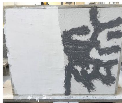
(d) Acabamento final com aplicação das últimas camadas de massa acrílica e preenchimento dos sulcos com resina epóxi
