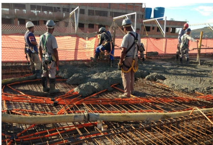
Figura 2 - Condições durante a concretagem do pavimento
