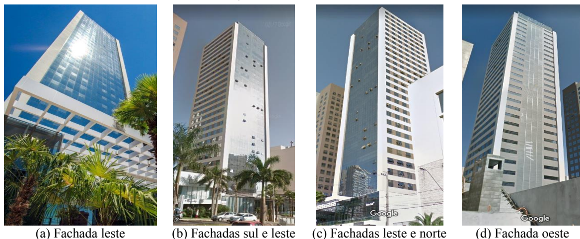
Figura 2 - Imagens das fachadas da edificação analisada
