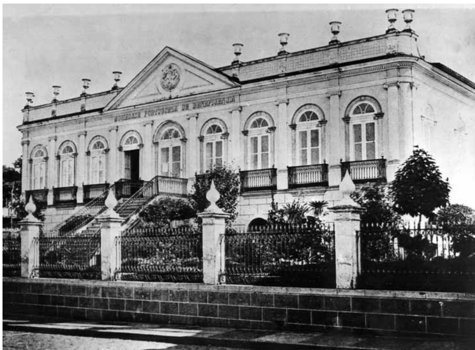
Figura 9 – Hospital da Sociedade Portuguesa de Beneficência (construção: 1873-1876). Em 1873, antes de ser dado início à realização da sede do hospital, foram introduzidas algumas modificações no projeto original de 1866, entre elas, a escada da fachada principal, executada com uma só frente. Fotografia anônima (possivelmente de Walter Sutton Bradley), c.1876. Acervo da Divisão de Iconografia e Museus (DPH/SMC/PMSP), São Paulo.
