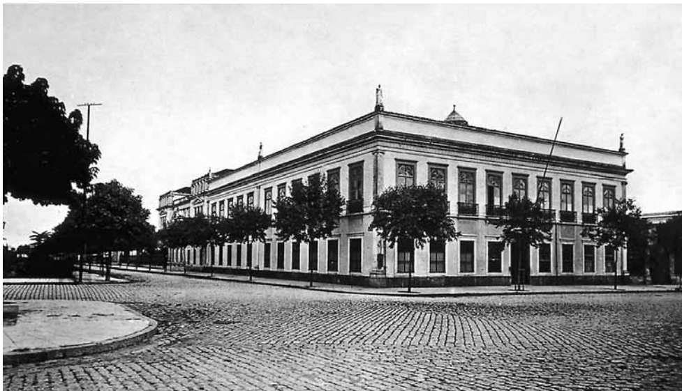
Figura 6 – Casa de Fidélis Nepomuceno Prates (construção: 1857 - c.1860). Segundo Ramos de Azevedo, o projeto da residência de Fidélis era do próprio proprietário, que foi o primeiro morador da cidade a construir uma sede de chácara em estilo neoclássico, influenciado pela arquitetura da Corte. Possuidor de uma mentalidade ainda ligada ao escravismo, mantinha no fundo do imóvel um tronco para o castigo de seus escravos urbanos. Postal da Escola Politécnica, ed. Duchein Irmãos, década de 1910. Acervo do Museu Paulista da USP. Reprodução de José Rosael.
