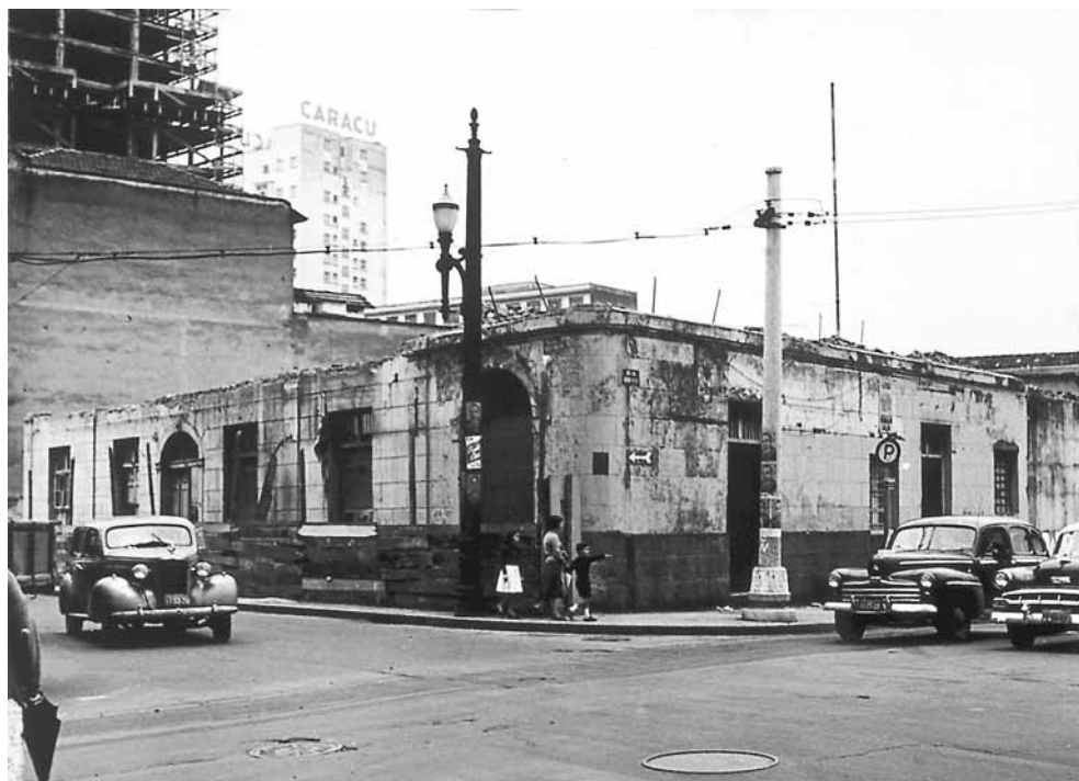
Figura 8 – Aspecto da demolição da antiga casa de José Maria Gavião Peixoto, ocorrida em novembro de 1958. Pode-se verificar que as paredes remanescentes das fachadas conservavam ainda o seu revestimento externo, porém, alguns indícios permitem pensar que a estrutura dessas paredes fosse integralmente constituída de alvenaria autoportante de tijolos, ou seja, as paredes externas da casa eram feitas de tijolos que suportavam os esforços sem o auxílio de reforço estrutural independente. Fotografia anônima, 1958, integrante do caderno Administração Ademar de Barros; monumentos, casas-museu, solenidades, nov./dez., 1958 . Acervo do Arquivo Histórico Municipal Washington Luís (DPH/SMC/PMSP), São Paulo. Reprodução de José Rosael.
