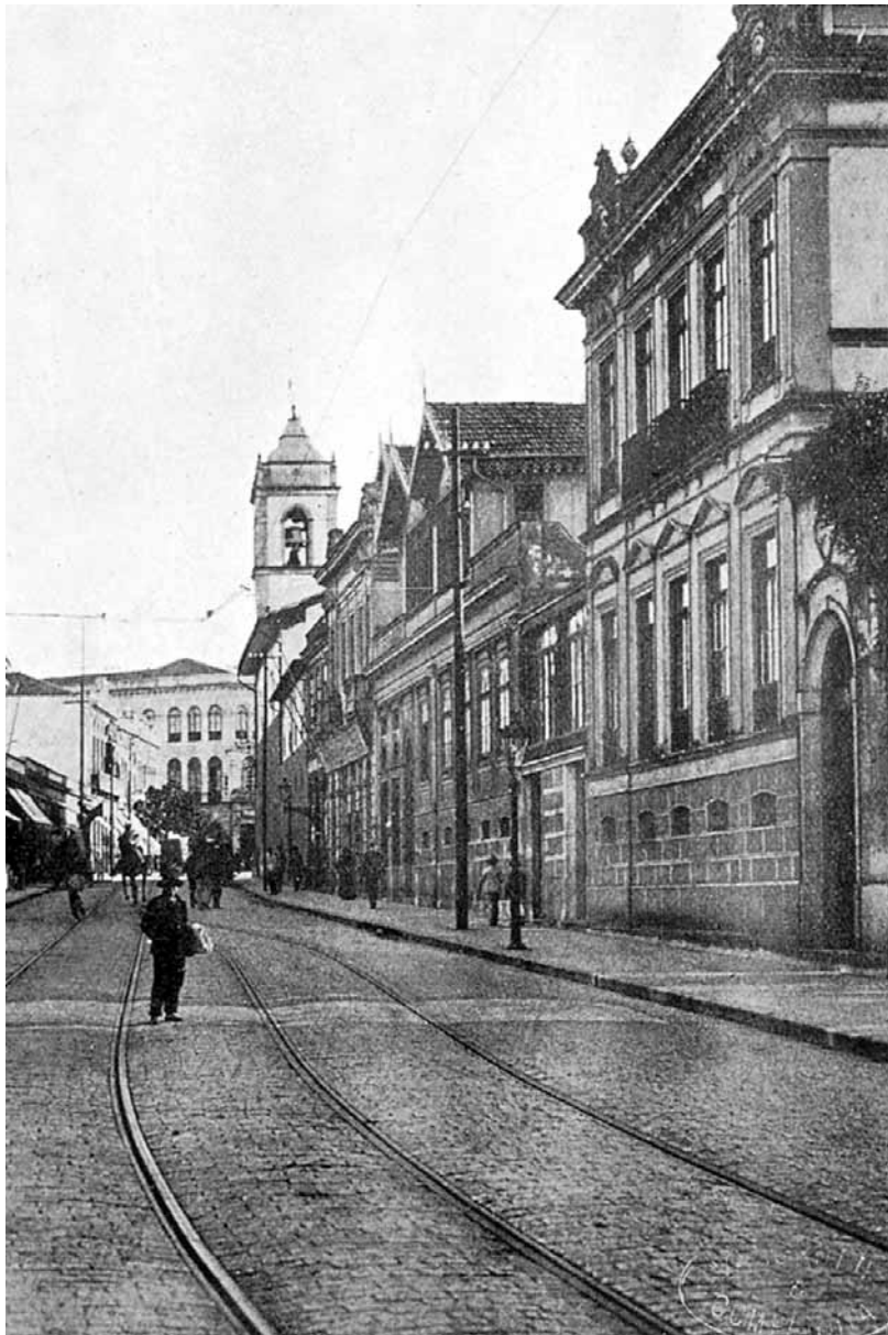
Figura 18 – Detalhe de vista da Rua Florêncio de Abreu datada do início do século XX. Vê-se à direita a casa do português Manuel Ferreira Leal, que teve auto de alinhamento lançado em 1881 e está datada de 1884 na fachada. As casas geminadas e assobradadas (isto é, de um só pavimento sobre porão, como eram então chamadas), vistas ao fundo, com mirantes em forma de chalé, pertenciam ao mesmo proprietário, Manuel Ferreira Leal, conforme documentação do AHMWL, e parecem traír a influência da “casa com torre” da arquitetura oitocentista açoriana. A edificação ainda existe e está localizada no atual número 111. Fotografia anônima (detalhe). São Paulo antigo e São Paulo moderno. 1554-1904 . Acervo da Biblioteca Central da Escola Politécnica da USP. Reprodução de José Rosael.
