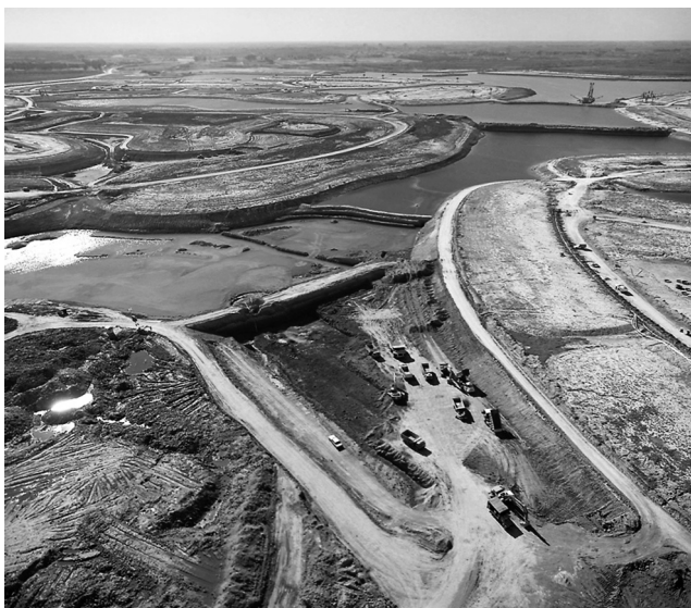
Figura 3. Movimiento de suelos para la construcción de rellenos de Nordelta. Fuente: material fotográfico suministrado por Nordelta SA.
