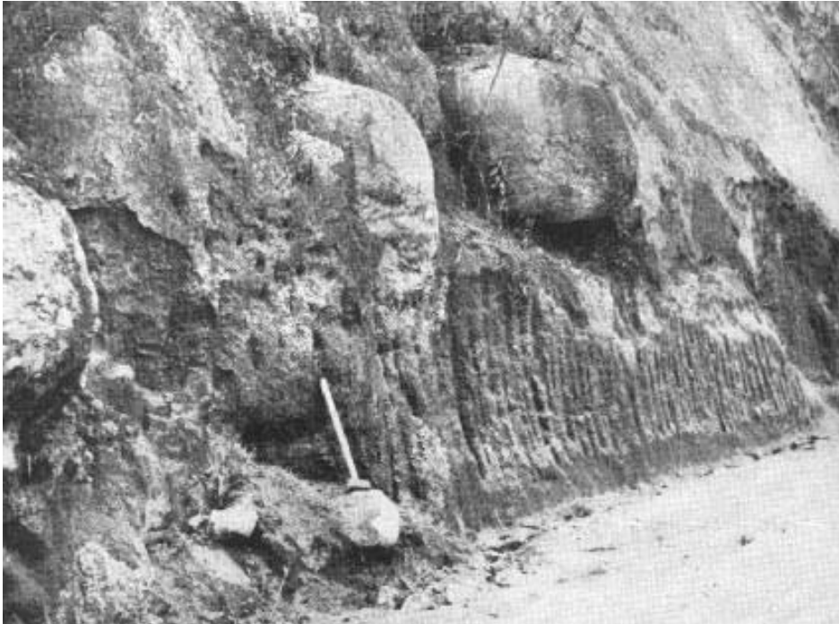
Fig. 71 – Algonquiano-huroniano. Blocos de granito post-algonquiano como núcleos mais resistentes na massa granítica, profundamente decomposta. Formas recentes de decomposição química motivada climaticamente. Região da série Açunguí, na estrada do Cerne. Primeiro planalto do Paraná. Santa Catarina.
