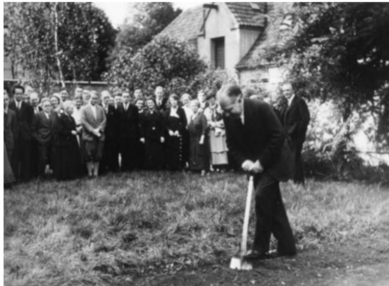
Figura 1 – Bohr iniciando a expansão do Instituto em uma foto simbólica datada de 1935-1936
