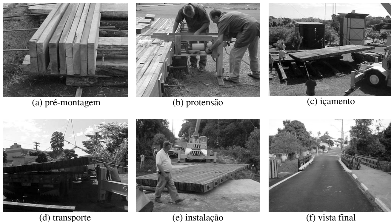
FIGURA 6. Sequência de construção.
