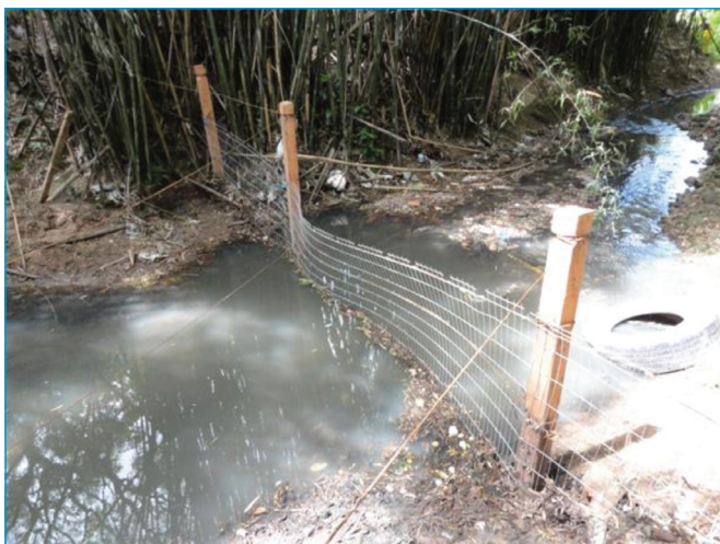
Figura 2 - Rede de retenção de resíduos sólidos na seção de monitoramento do arroio Cancela-Tamandai.
