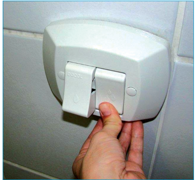
Figura 2 - Válvula de descarga de duplo acionamento instalada para o terceiro período de coleta de dados.
