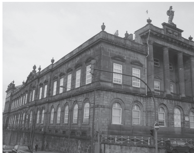
Figura 6: Fachada Sul e parte da nascente do Hospital Geral de Santo António (fotografia da autora, dezembro 2010)
