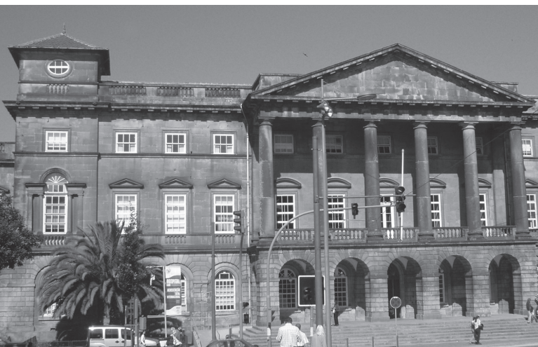
Figura 3: Pórtico nascente do Hospital Geral de Santo António (fotografia da autora, junho 2007)
