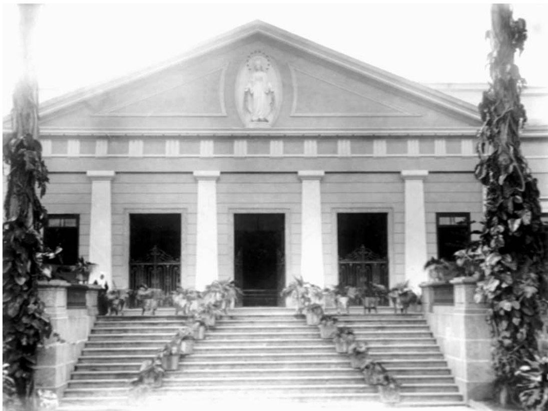
Fachada do prédio do Recolimento das Órfãs de Santa Tereza (acervo MIS).
