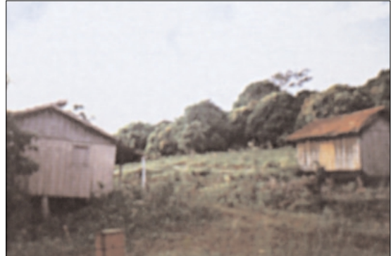
Figura 2 - Anexos domiciliares: casa de madeira com teto de telha desabitada, servindo como depósito de cereais e madeira infestada por T. sordida e P. megistus (à esquerda); paiol de madeira (à direita) na zona rural do município de Paçandú, PR. Agosto/1995.
