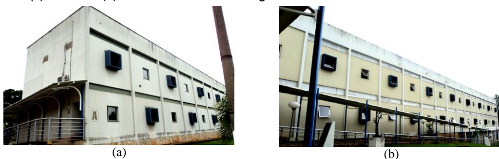
Figura 2 - (a) Bloco A e (b) Bloco B das Escolas de Engenharia da UFG
