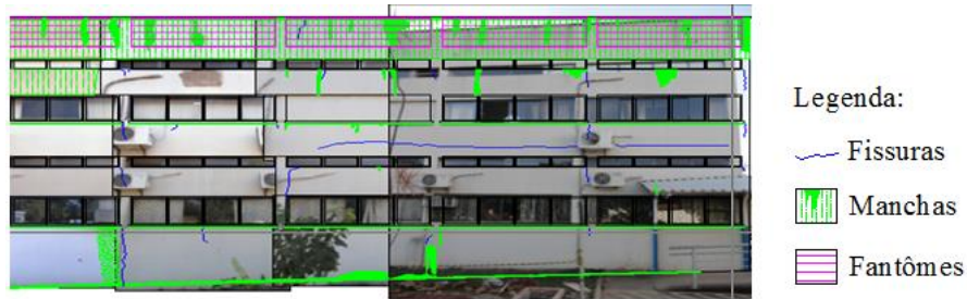
Figura 4 - Exemplo da confecção dos mapeamentos das manifestações patológicas da fachada sul do Bloco A
