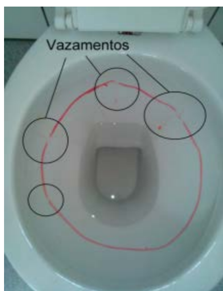
Figura 2 - Quatro filetes em bacia sanitária no Edifício X
