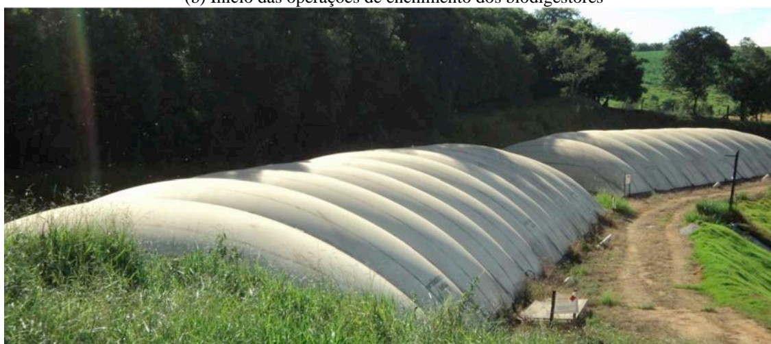
(c) Biodigestores de modelo canadense implantados, com destaque para o gasômetro de PVC
