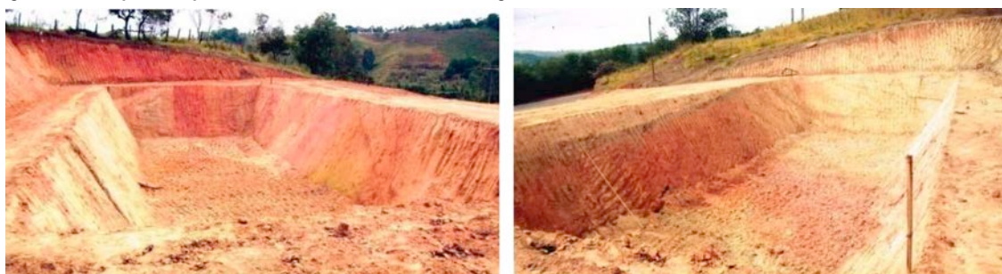
(a) Escavação dos biodigestores
