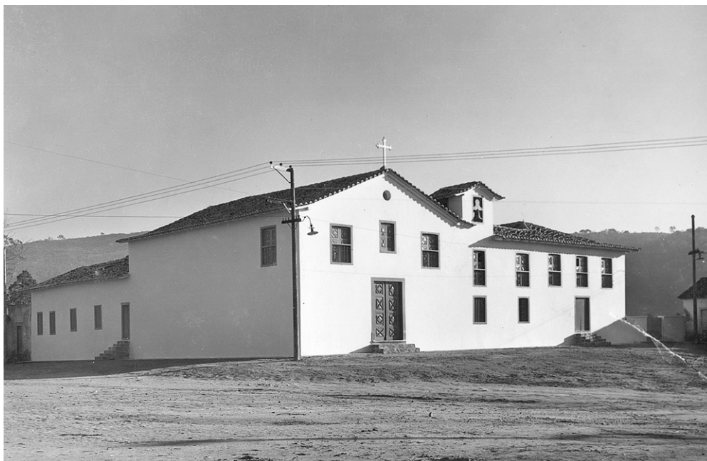
Figura 1: Igreja Nossa Senhora do Rosário – Fachada frontal e lado direito. Fonte: Coleção Oficial nº985 – Herman Hugo Graeser – Arquivo Fotográfico, IPHAN/SP
