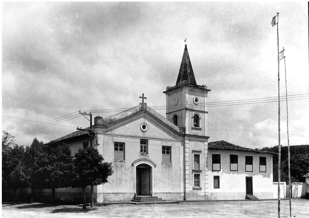
Figura 2: Igreja Nossa Senhora do Rosário – Fachada Frontal. Fonte: Coleção Oficial – neg. Nº114 – Novembro de 1937 - Herman Hugo Graeser – Arquivo Fotográfico, IPHAN/SP
