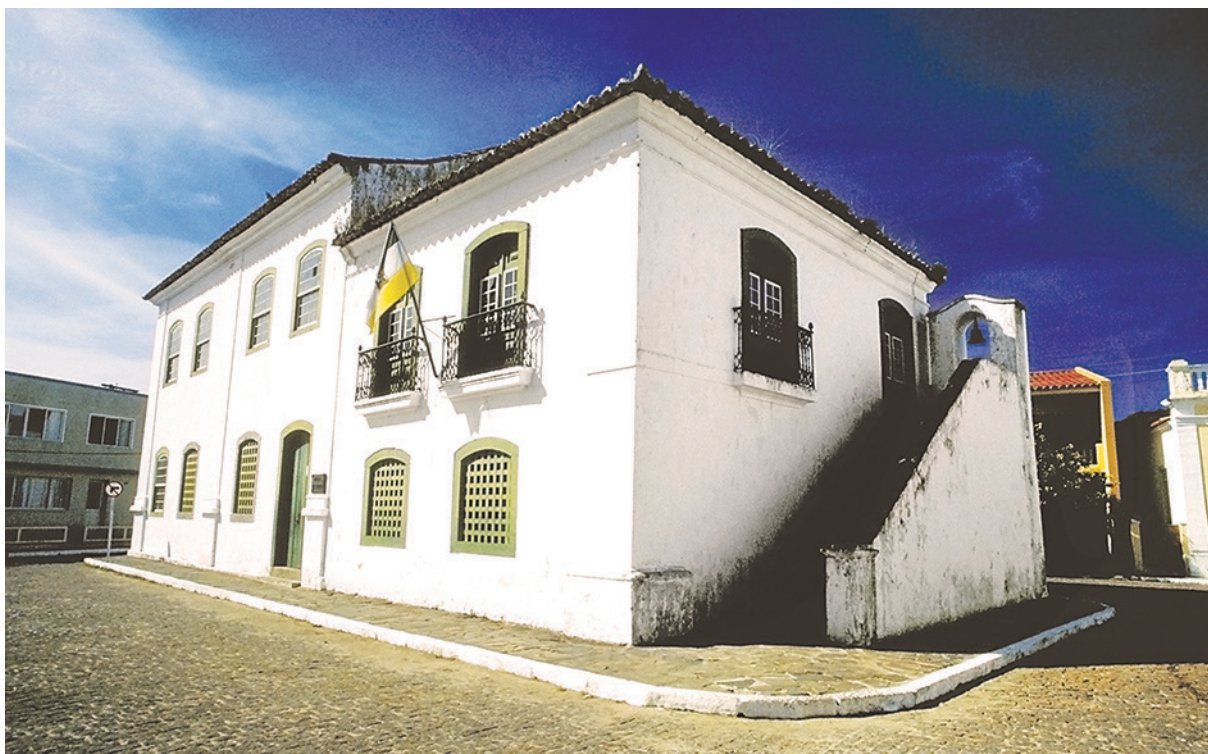
Figura 2: Casa de Câmara e Cadeia de Laguna/SC, tombada pelo Iphan. Fonte: Acervo da Superintendência do Iphan em Santa Catarina.
