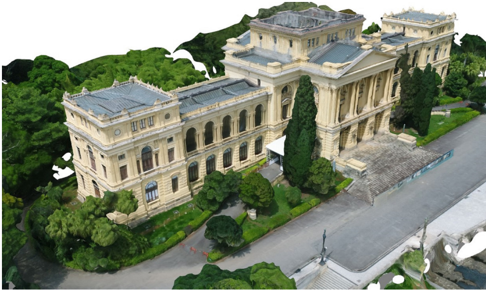
Figura 19 – Maquete eletrônica gerada por levantamento aéreo (drone) do edifício-monumento do Museu Paulista.
