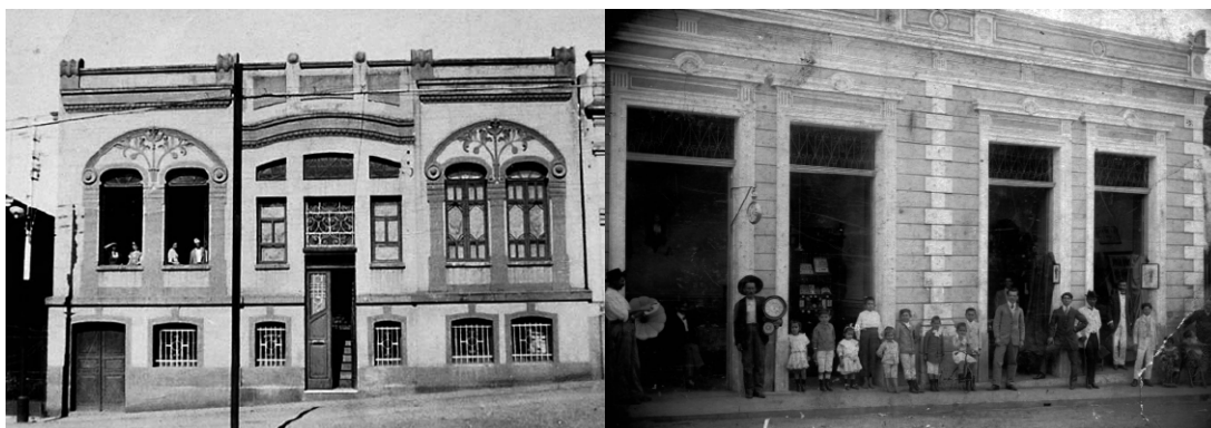
Figura 3e (moradia da família Bincoletto na Praça XV de Novembro, nº42) e Figura 3f (edifício de uso misto da família Landini na Rua Treze de Maio, nº146-152) – Edificações projetadas e construídas por Paschoal Artese no início do século XX. Fonte: arquivo pessoal de Natalia C. Rezende e Arquivo do Centro da Memória Rio-Pardense Rodolpho José Del Guerra.
