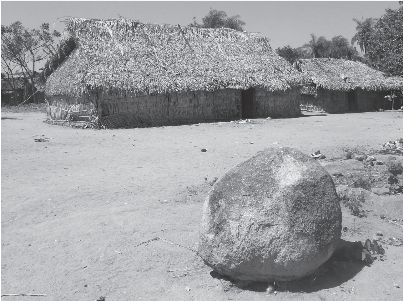
Figura 6. Casas tradicionais Mebêngôkre feitas com palha de babaçu ( Attalea speciosa Mart.).
