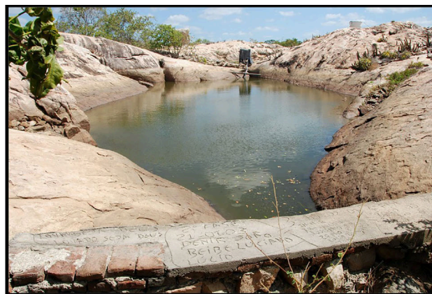
Figura 3 - Imagem de um Tanque de Pedra com pequena barragem de alvenaria. Fonte: Projeto Daki – Semiárido Vivo (2022).
