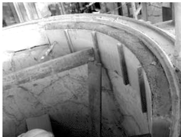
Figura 12: Concretagem do topo do cadinho com material denso. [Figure 12: The top of crucible's lining repaired using dense refractory.]
