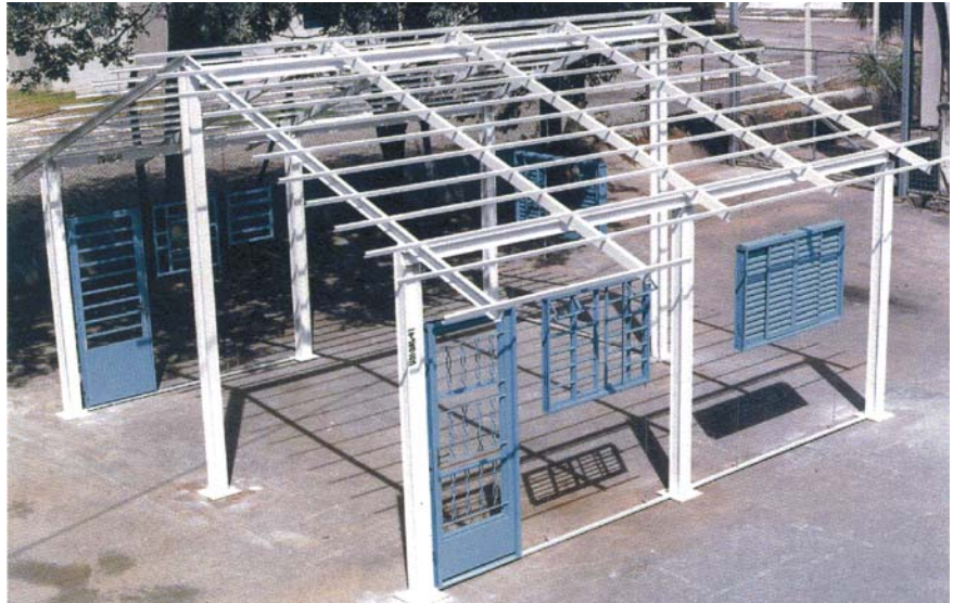
Figura 2 - Estrutura Metálica da casa Usiteto. (Fonte: Usiminas, 2001).
