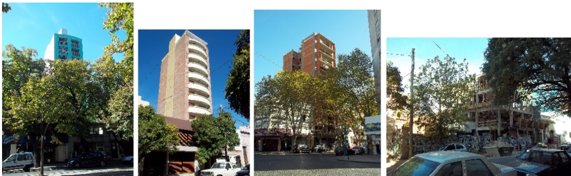
Figura 6 - Registro fotográfico de edificios en la manzana céntrica donde se emplazaría el edificio analizado
