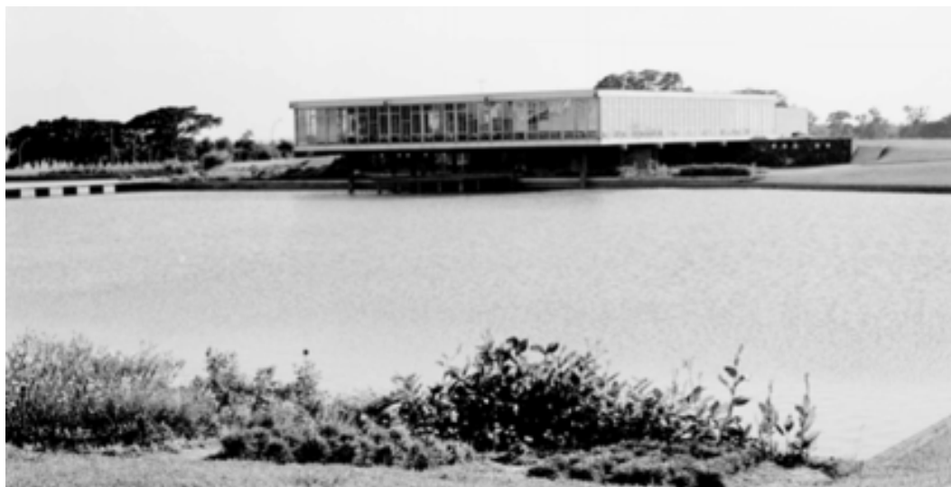
Figura 3 - Refinaria Alberto Pasqualini (Refap), Petrobras, refeitório
