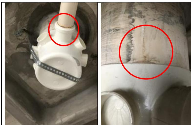
Figura 9 - Vazamentos em teste de estanqueidade da calha
