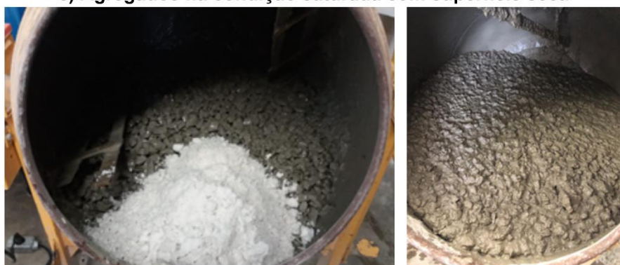
d) Disposição dos materiais na betoneira
