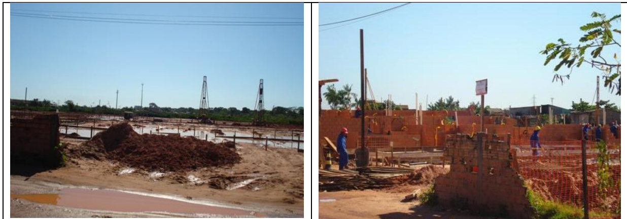
Figura 12. Início de construção pela COHAB do Conjunto Residencial Liberdade às margens do Igarapé Tucunduba.
