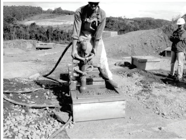
Figura 3 – Enriquecimento do CCR - adensamento
