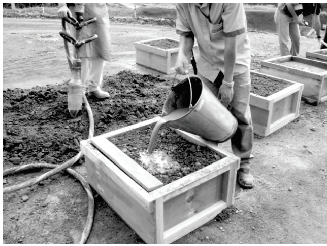
Figura 2 – Enriquecimento do CCR - aplicação da calda
