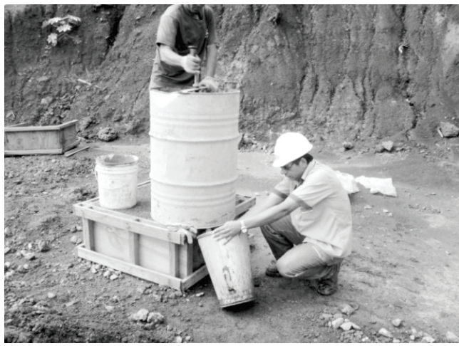
Figura 1 – Detalhe do preparo da calda
