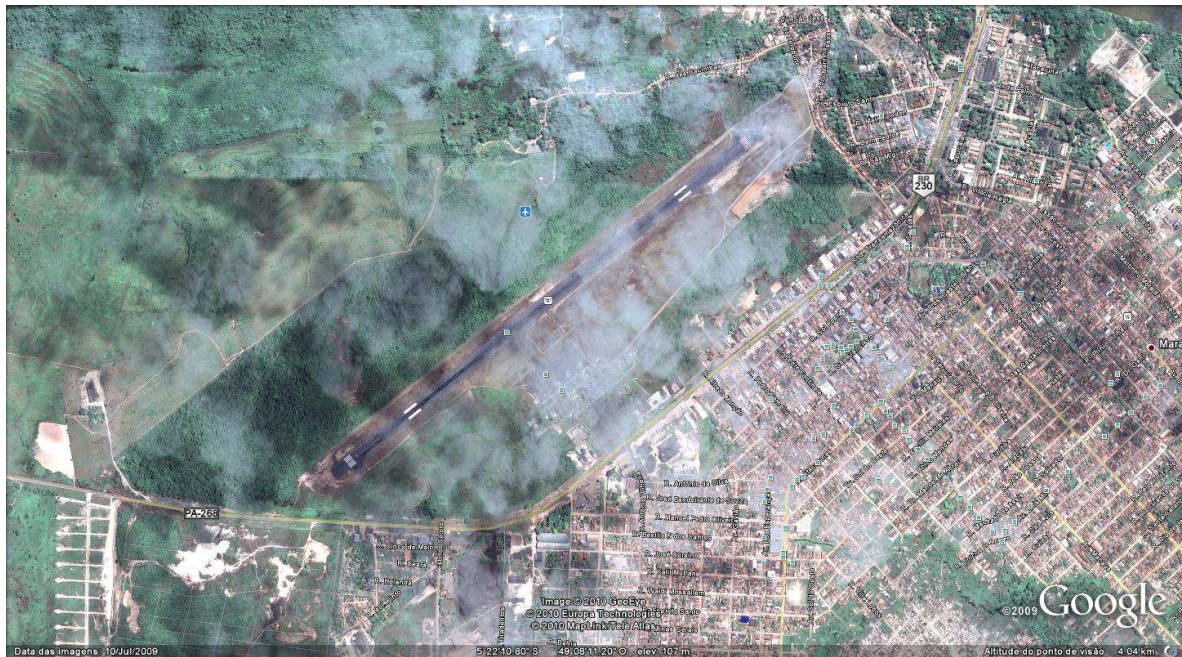
Figura 3 : O aeroporto de Marabá já cercado pela malha urbana
