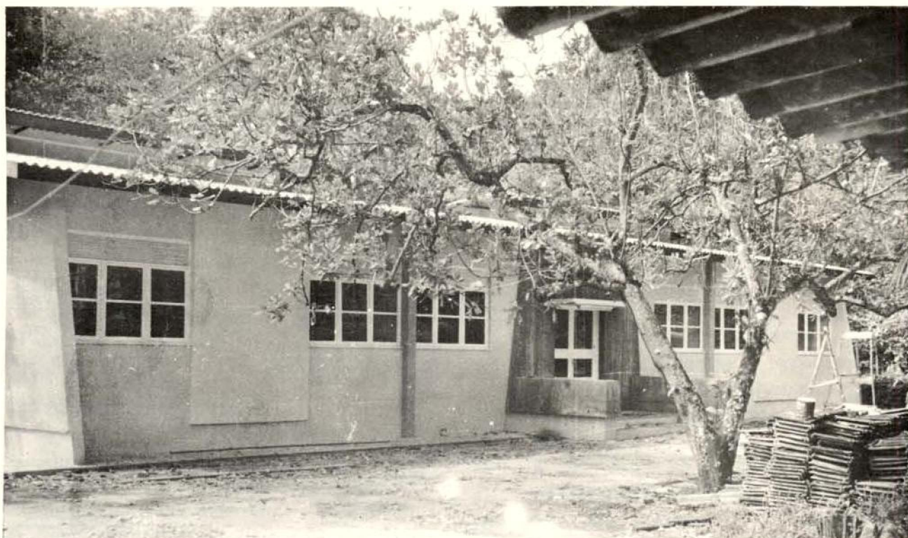
Fig. 2 — O mesmo prédio, reformado e ampliado pelo CNPq em 1962, hoje sem espaço suficiente para conter coleções e pessoal.
