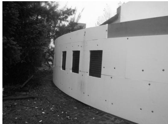
Figura 5 - Colocación de EPS en la cara este
