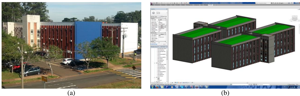
Figura 3 - (a) Vista do prédio administrativo; e (b) modelo 3D original na interface do software Revit (Autodesk)
