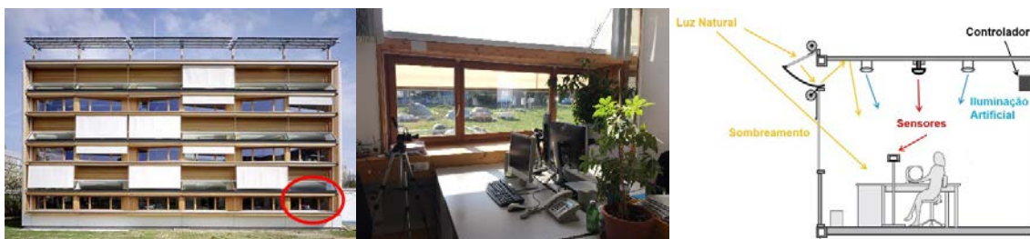
Figura 5 - (a) Fachada Sul do LESO-PB. Em destaque a sala LE001 onde o experimento foi realizado. (b) Interior da sala. (c) Localização usual dos sensores
