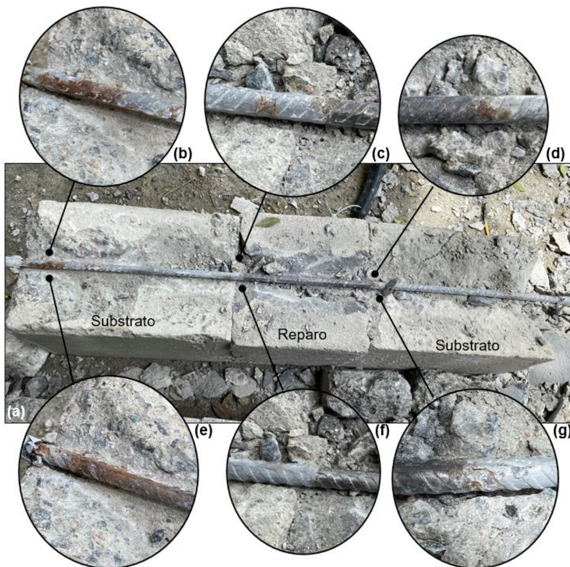
Figura 13 - Inspeção destrutiva de amostra reparada - argamassa com 10% de SCA
