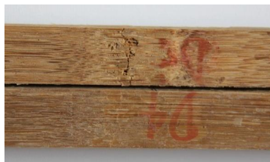
(b) Após a abertura da viga
