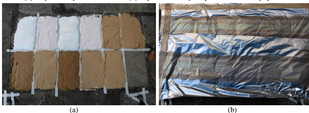
Figura 10 - (a) Emplastro aplicado no lioz e (b) Superfície de aplicação coberta com papel alumínio
