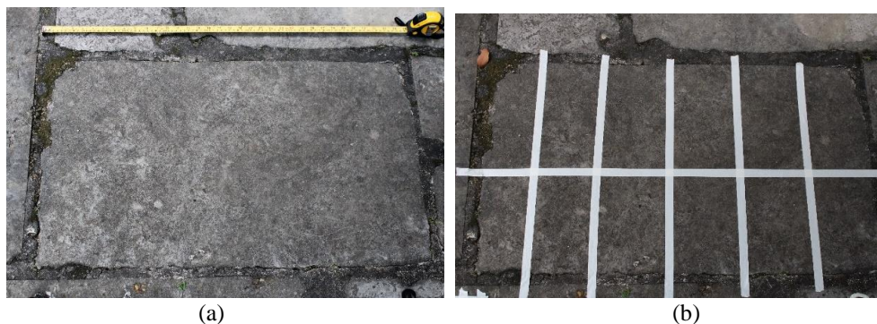
Figura 9 - (a) Pedra escolhida para aplicação do emplastro e (b) Subdivisão das áreas de aplicação do emplastro
