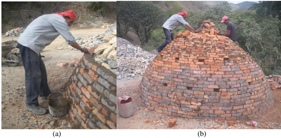
Figura 6 - Formación del montículo y construcción del capelo
