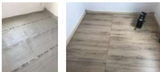
Figura 9 - Execução do sistema de piso flutuante LaMoCeCamp para ensaio em campo
