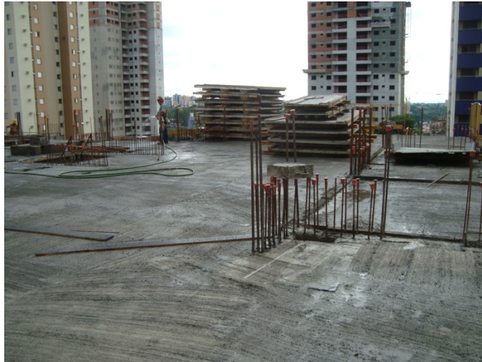
Figura 10 - Limpeza na área de trabalho e armazenagem de formas no pavimento
