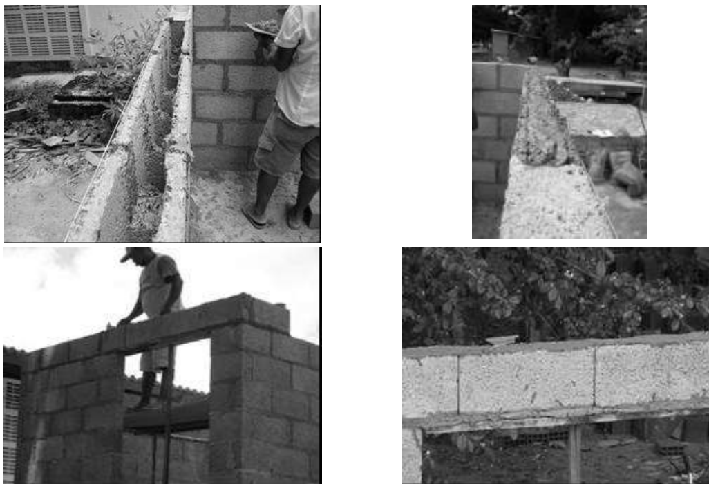
Figura 4 - Execução da verga e da contraverga com blocos EVA
