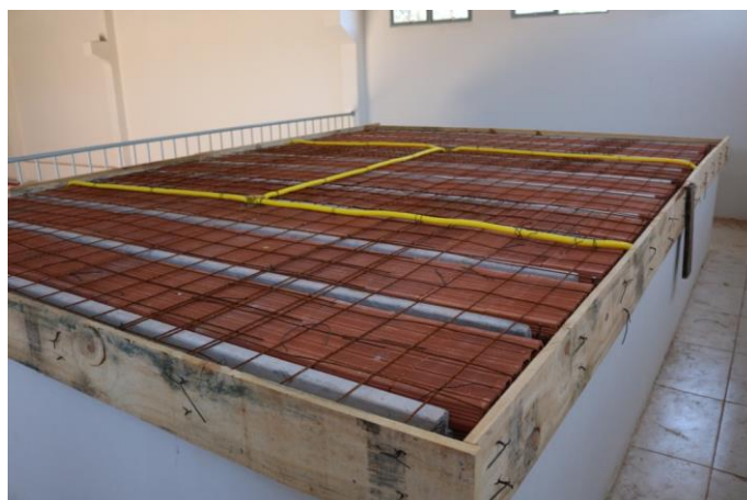
Figura 4 - Montagem da composição no local de ensaio
