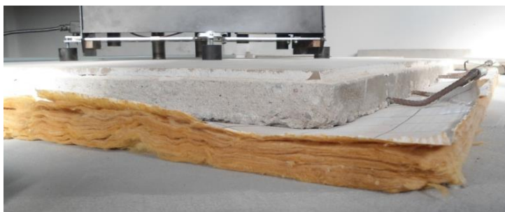
Figura 6 - Pannel de lâ de vidro 15 mm sob contrapiso
