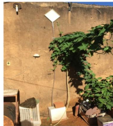
(b) Fachada leste da autoconstrução
