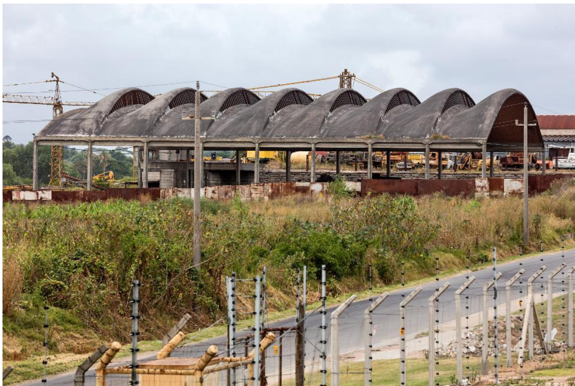
Figura 1 -Tomada geral das abóbadas gaussianas descontínuas do Galpão de Palenga, construído por Eladio Dieste em Montevideo, em 1981
