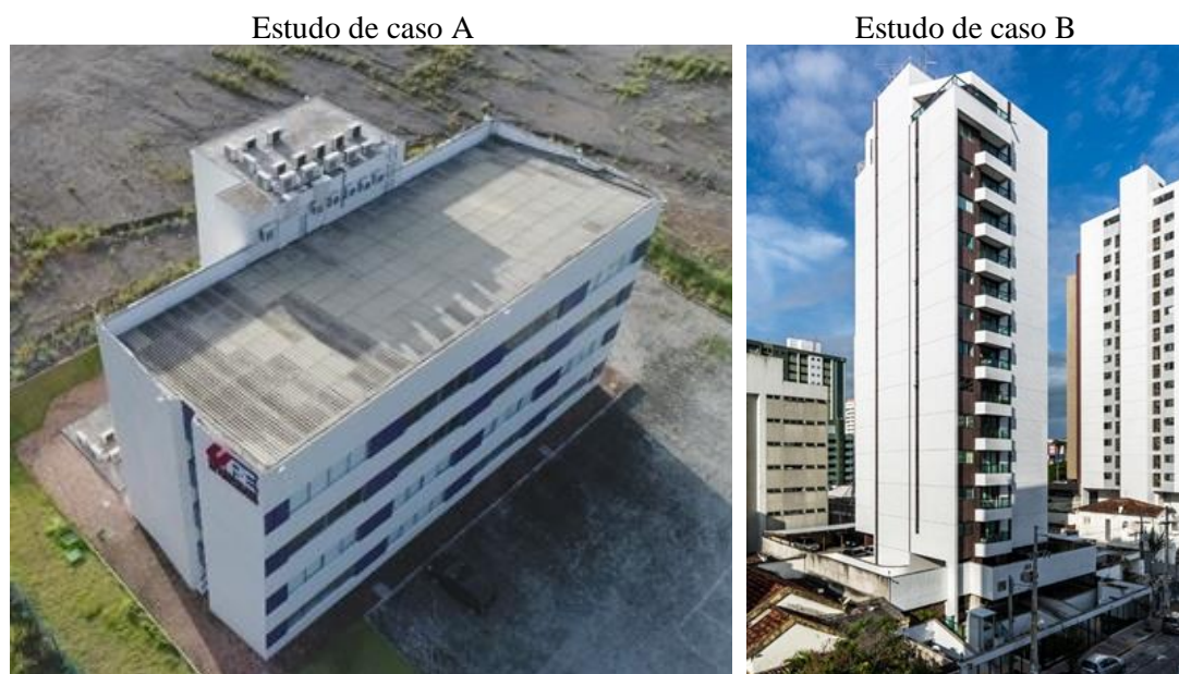
Figura 4 - Edificações selecionadas para os estudos de caso
