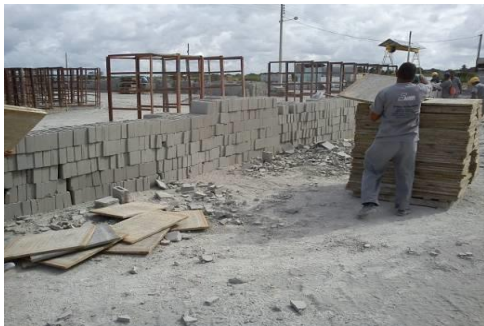
(e) Armazenamento no pátio de estocagem
