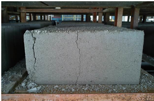
(c) Bloco fissurado
